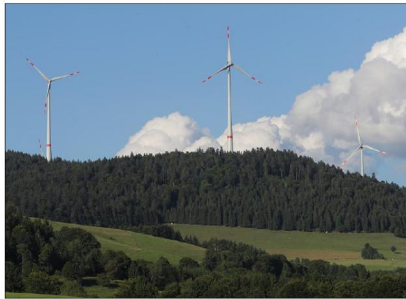
Vue sur trois des cinq éoliennes du parc du Rohrenkopf, sur les hauteurs de Gersbach. Photos L'Alsace
