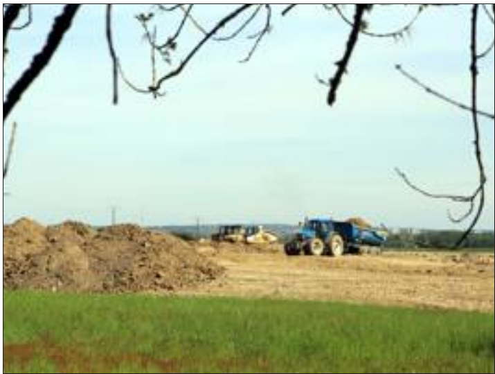
Depuis trois semaines, les travaux de terrassement ont repris sur le site de près de 5 hectares. Photo Dom Poirier
