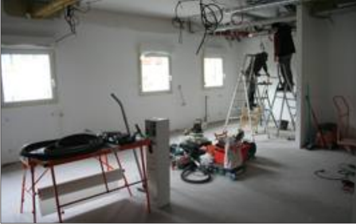
Un nouvel espace d'activités comprenant notamment une cuisine thérapeutique, est en cours d'aménagement au rez-de-chaussée de l'établissement dannemarien.
