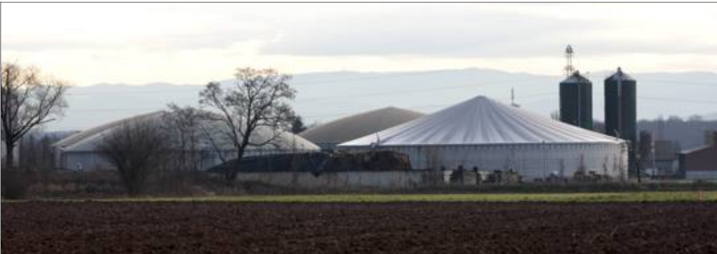
L'unité de méthanisation Agrivalor, ouverte il y a deux ans à Ribeauvillé, produit du méthane, de l'électricité et de la chaleur à partir de déchets organiques : « Il y a de la place pour 30 unités de cette taille en Alsace », selon l'Ademe. Photo Thierry Gachon
